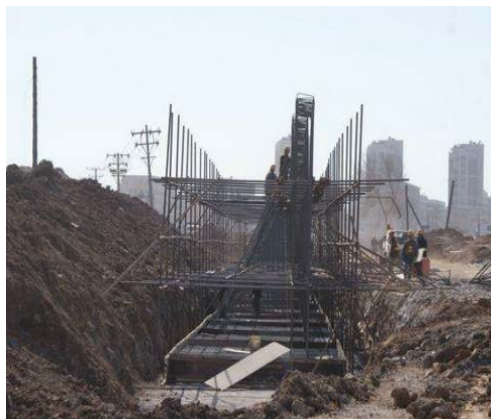
(1) 扶壁式挡土墙现场施工图
